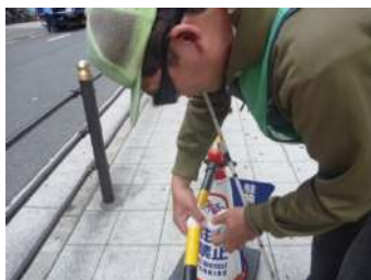
駐輪禁止エリアにあるコーンバーの修理も余力があればしています。
